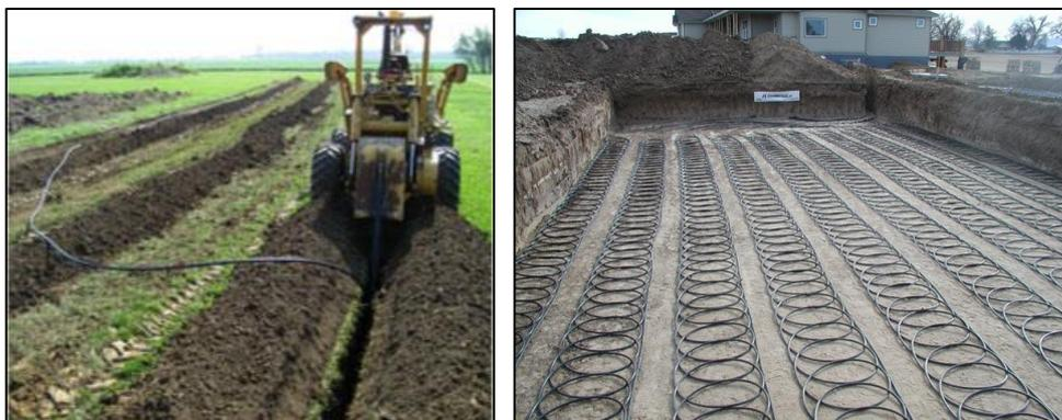
Figura 4: Esempi di circuito chiuso con scambiatori orizzontali: singolo tubo diritto (sx), slinky (dx)
