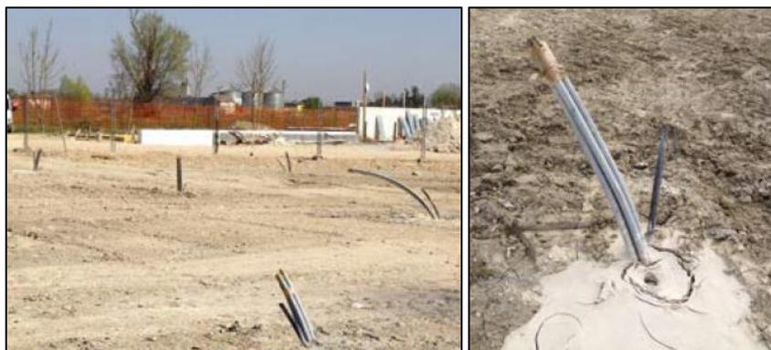
*Figura 5: Campo di sonde geotermiche verticali immediatamente dopo il completamento*
