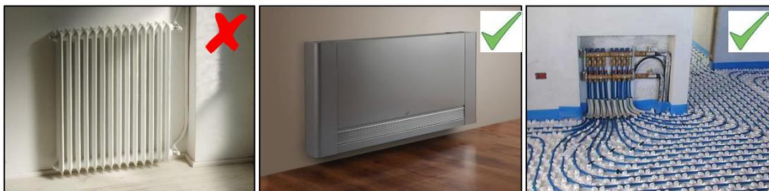
Figura 8: Tipologie usuali di terminali di riscaldamento, da sinistra: radiatore, ventilconvettore, pannelli radianti
